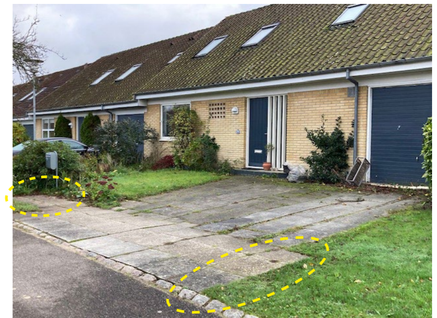
Overkørslen m. de eksisterende fortovsfliser flugter ikke med de enkelte matriklers belagte indkørsler. Det samme m. postkasser.
