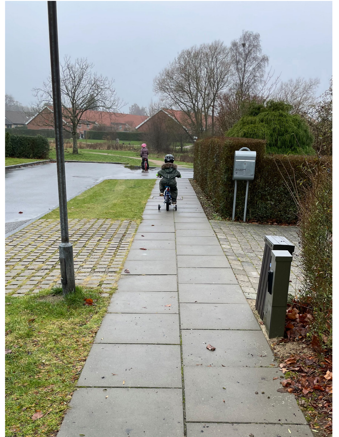
Gennemgående fortove, betonfliser 60 x 60 cm og et overkørselsareal i beton-græsarmering.
